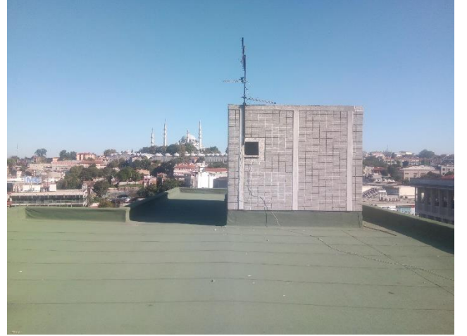
Şekil 19 ve 20. 3 ve 4. blokların teras çatıları (2018).
