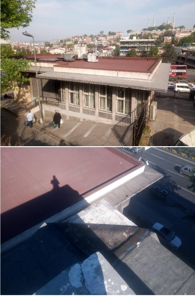
Şekil 27 ve 28. Aslına uygun olmayan teras, saçak ve harpuşta kaplamaları (2018).
