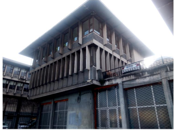
Şekil 13. Banka ve yemekhane binası (2018).
