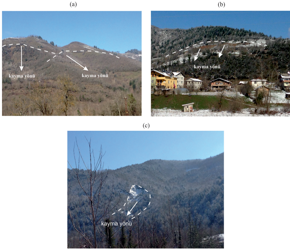
Şekil 5 (a,b,c). Çalışma alanındaki Buğurlar köyü civarında gözlenen heyelanlar ve kayma yönleri.
