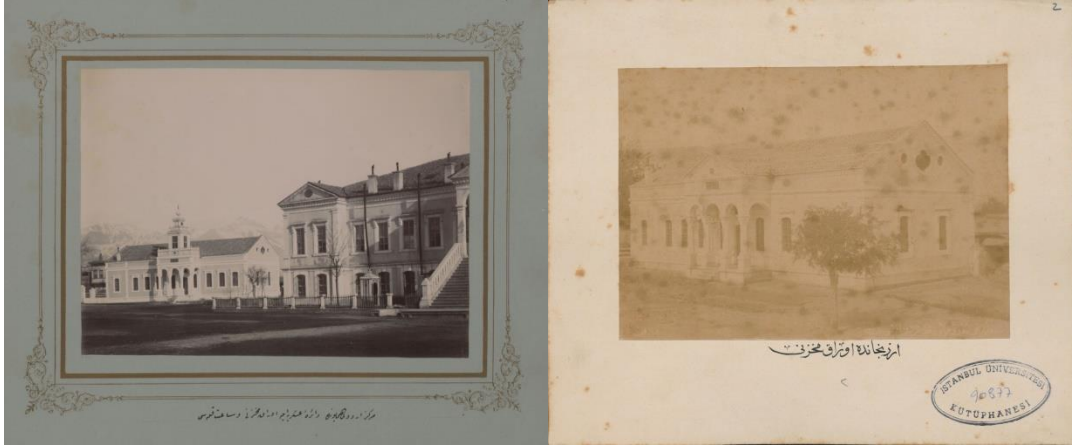
Şekil 7-8. Soldaki fotoğrafta Bâb-ı Müşiri'nin yanında yer alan Evrak Mahzeni binası, sağdaki yıpranmış fotoğrafta ise saat kulesi eklenmeden önce Evrak Mahzeni binasının görüntüsü.
