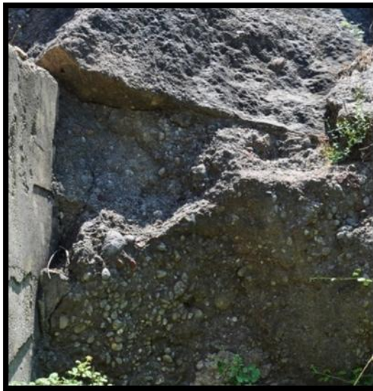
Şekil 3. Karacaören I Barajı su tünelinin yanında Aksu Formasyonu'na ait konglomeralar
