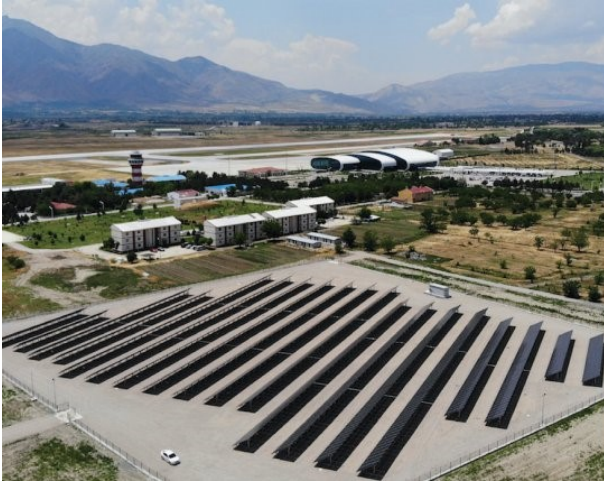
Şekil 5. Erzincan Havalimanı güneş enerjisi santralinin görünümü [41].
