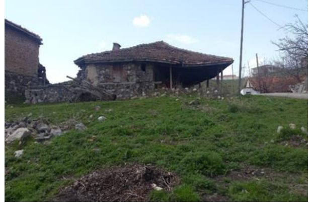
Fotoğraf 7- Çavuşlar Mahallesi Photograph 7- Çavuşlar Neighbourhood
