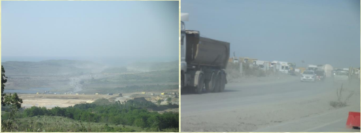
Şekil 11: 3. Havaalanı inşaatı sırasında oluşan toz emisyonları
