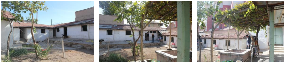
Şekil 13: 1 Nolu konutun bahçeden görünüşü (Sungur, 2017)
