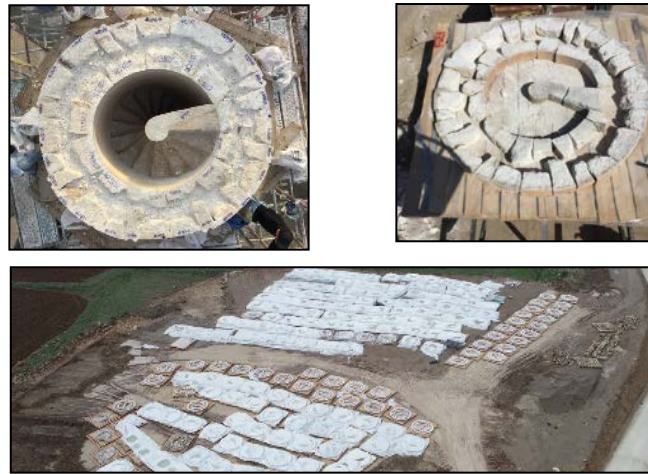
Fig. 3. Sultan Süleyman Camii minaresinin birim yapı elemanlarının numaralandırma, söküm çalışmaları (a,b) ve taşıyıcı platformların üzerine alınarak depo alanına taşınması (c)
