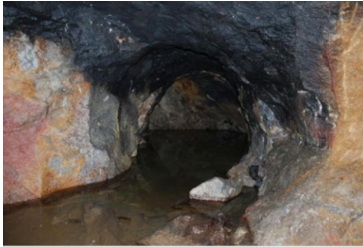
Şekil 6. Çekya'da bulunan eski bir madende ateş kurma ile kazı sonrası tavanda oluşan ıslak (Lednicka ve Kalab, 2016; Fotoğraf: Lednicka).
