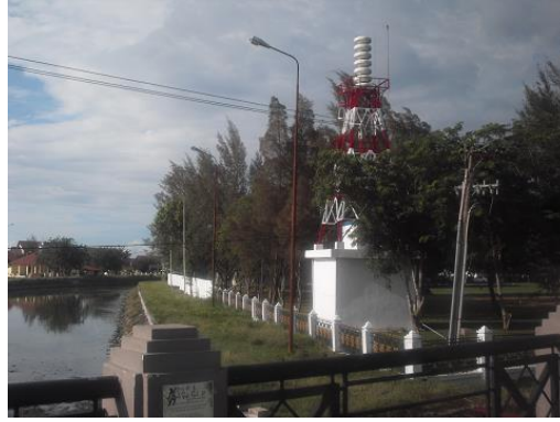
Şekil 14. Kente Yerleştirilen Tsunamiye Yönelik Erken Uyarı Sistemi
