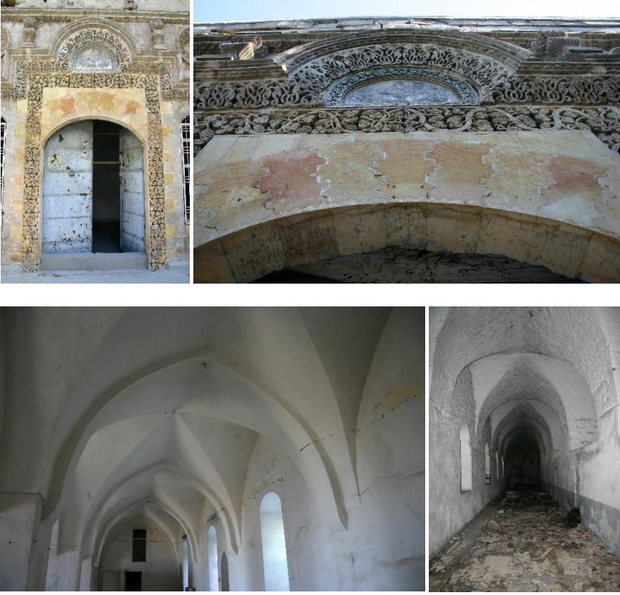
Resim 7, 8, 9, 10, 11, 12. Mardin Kışlası'nın 2005 yılında, restorasyondan önceki hali (Fotoğraf: Abdülgani Tarkan)
