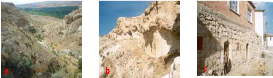
Şekil 11. A, B-Sarıhıdır koyu evlerin duvarlarında kullanılan eriyonitli tuf kayalarının alındığı taş ocağı, C-Bu taşların kullanıldığı evler [Barış, 2005].
