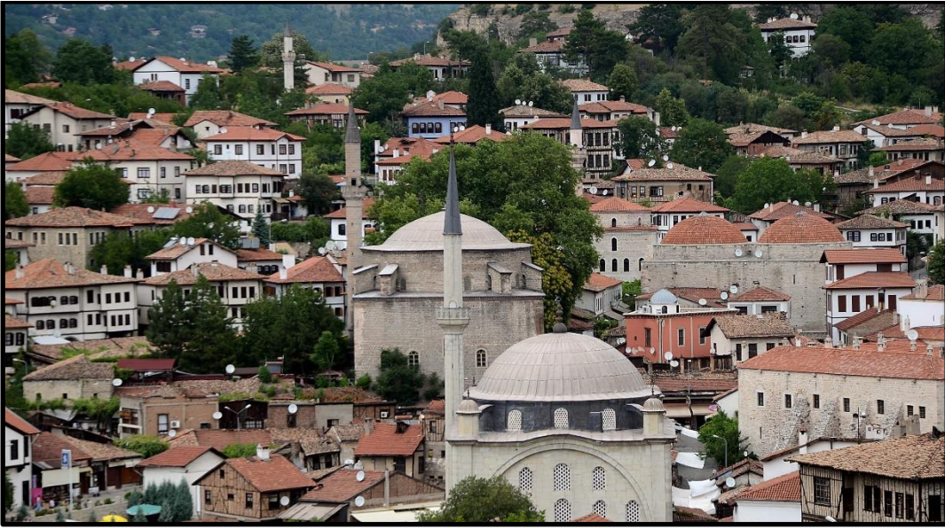
Fotoğraf 4: İzzetpaşa Mahallesi (İzzetpaşa Camii)
