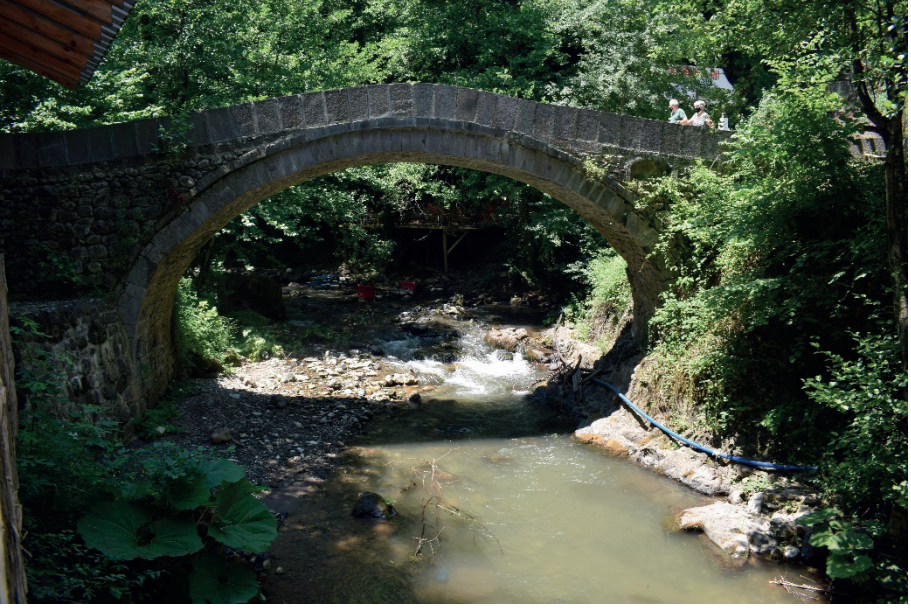
Res. 15: Başiskele Servetiye Köprüsü Doğu Cephe
