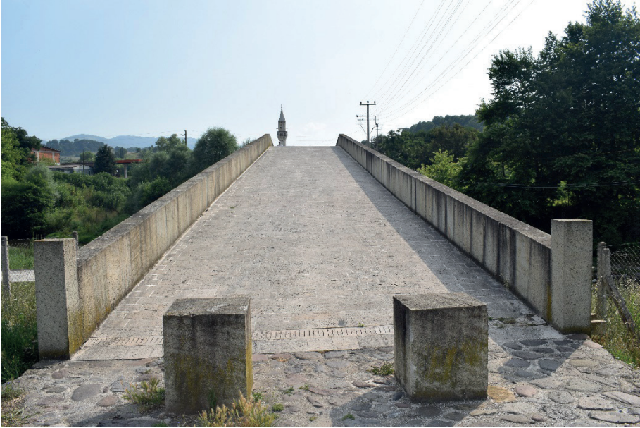
Res. 14: Karamürsel Valide Sultan Köprüsü Tabliye
