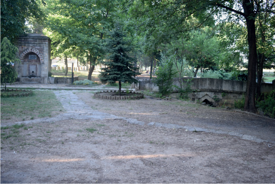
Res. 1: Çayırova Hünkâr Köprüsü ve Çeşmesi
