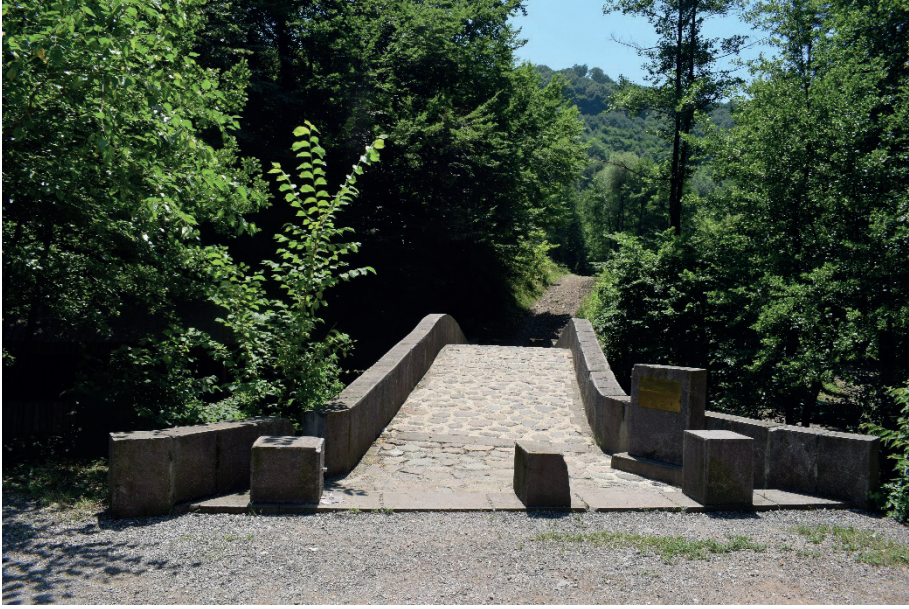
Res. 17: Başiskele Servetiye Köprüsü Tabliye
