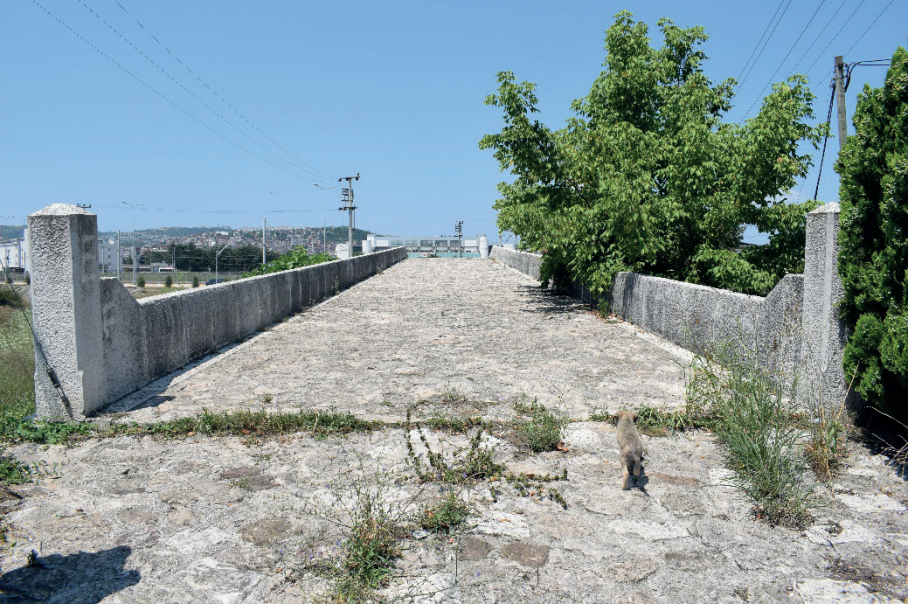
Res. 11: İzmit Kethüda Caferi Hatun (Kilezdere) Köprüsü Tabliye
