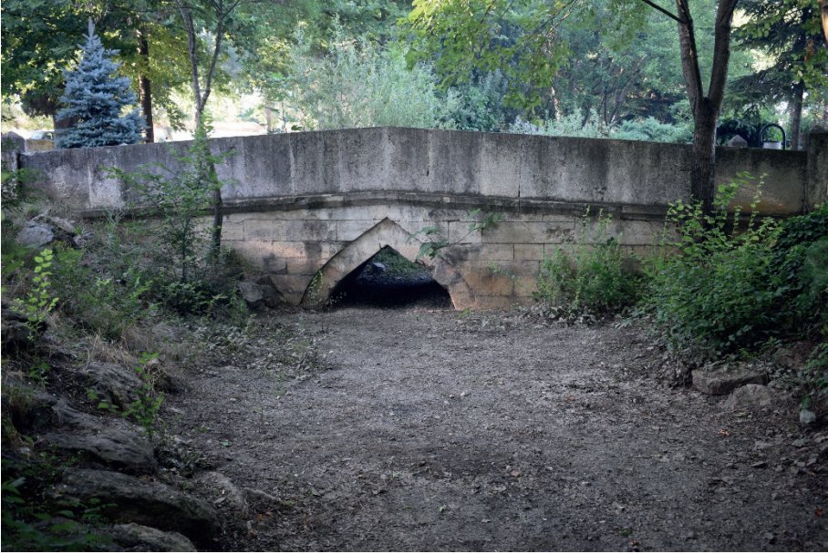
Res. 2: Hünkâr Köprüsü Güney Cephe
