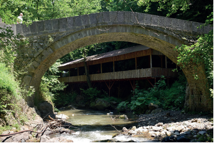
Res. 16: Başiskele Servetiye Köprüsü Batı Cephe
