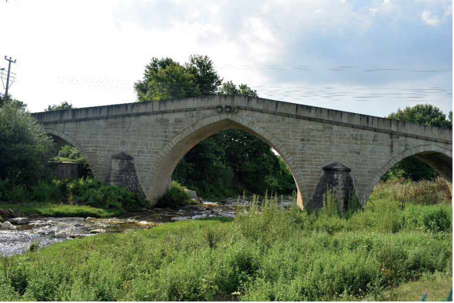
Res. 12: Karamürsel Valide Sultan Köprüsü Doğu Cephe
