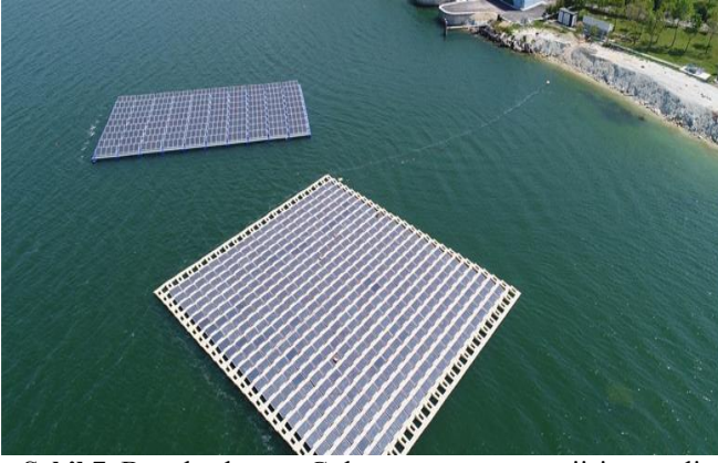
Şekil 7. Büyükçekmece Gölü yüzer güneş enerjisi santrali (“İBB Türkiye’nin İlk Yüzer Güneş Enerji Santralini Kurdu.”, 2020)
