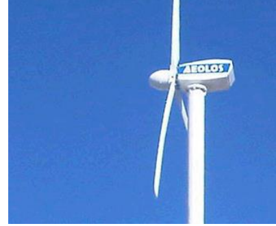
Şekil 6. Aelos-H 3 kw rüzgar türbini ("3 kw Rüzgar Türbini", 2020)
