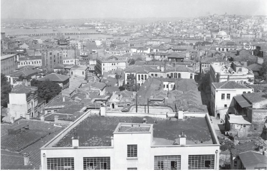
Şekil 13. 1940 yılına ait Yarım Han çatı fotoğrafı (Encümen Arşivi).
