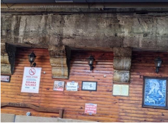
Resim 4: Kütüphane binasının taş konsolları
