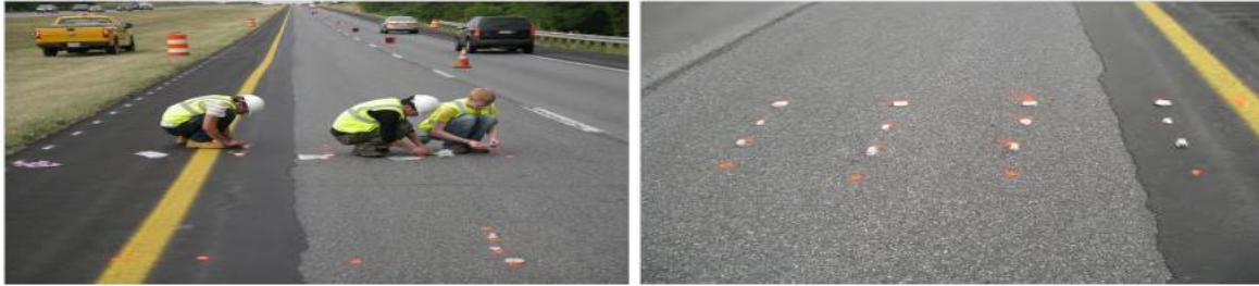
Şekil 6. RFID kartlarının asfalt yol kaplamasına montajı [14]
