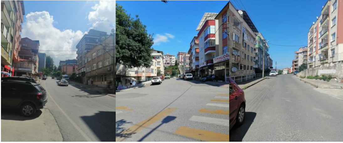
Şekil 15. Kalkınma Mahallesi seçilen alan
