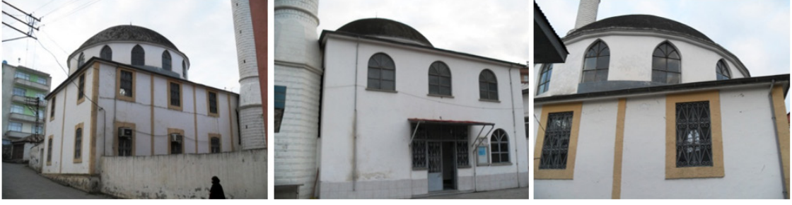
Resim 15. Dürbinar Camisinin restorasyon öncesine ait görüntüler
