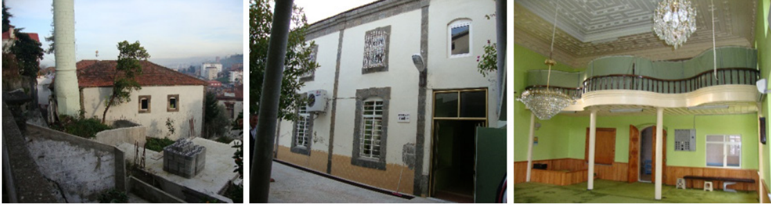
Resim 18. Orta Mahalle Camisi restorasyon öncesi fotoğrafları
