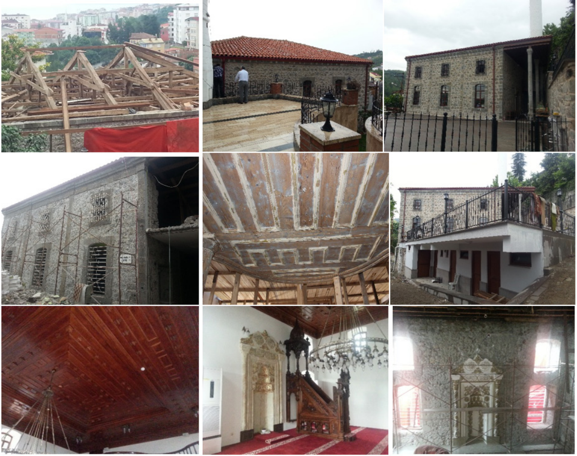
Resim 19. Orta Mahalle Camisi restorasyon süreci görselleri
