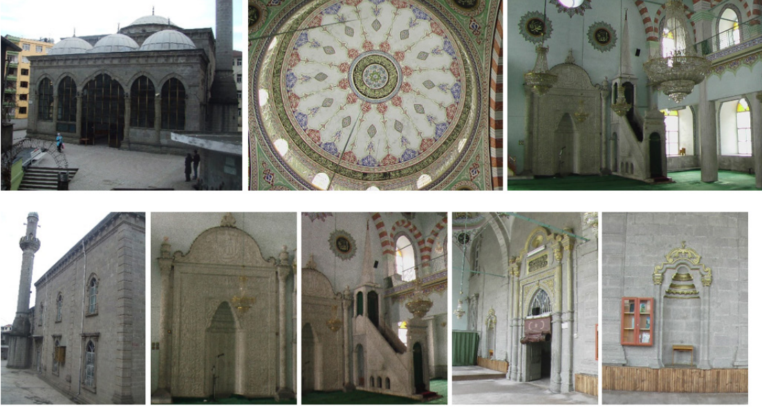
Resim 12. Yeni Cami restorasyon öncesine ait fotoğraflar
