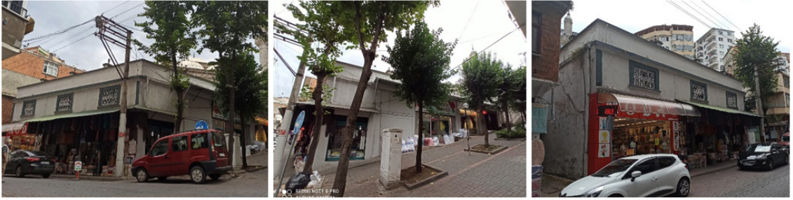
Resim 3. Yeni Cami avlusu altındaki kargir altı adet dükkân görselleri
