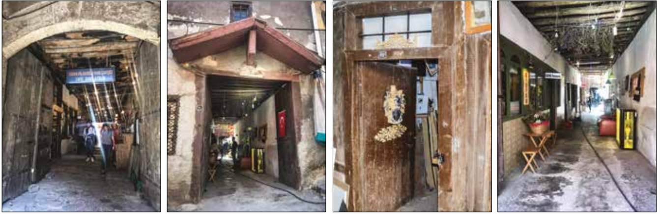
Fotoğraf 11: (a) Pilavoğlu Han arka çıkış kapısı. / (a) Back exit door of Pilavoğlu Khan. Fotoğraf 11: (b) Ön giriş kapısı. / (b) Front entrance door of Pilavoğlu Khan. Fotoğraf 11: (c) Han içi ahşap kapı. / (c) Wooden door inside Khan. Fotoğraf 11: (d) Yeni müdahaleler. / (d) new interventions.
