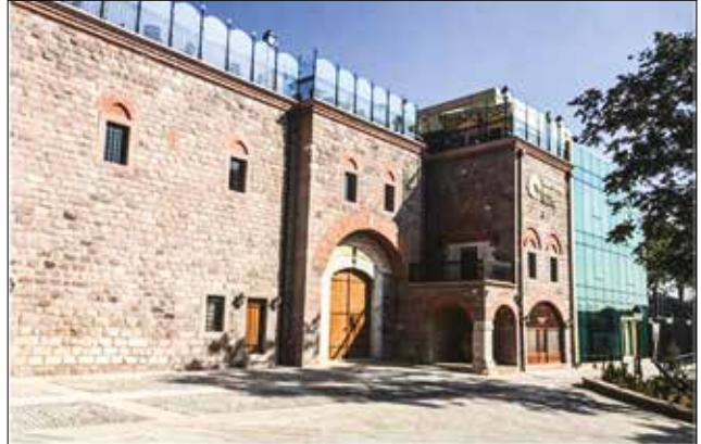
Fotoğraf 8: Restorasyon sonrası Zafran Han. / Zafran Khan after restoration.
