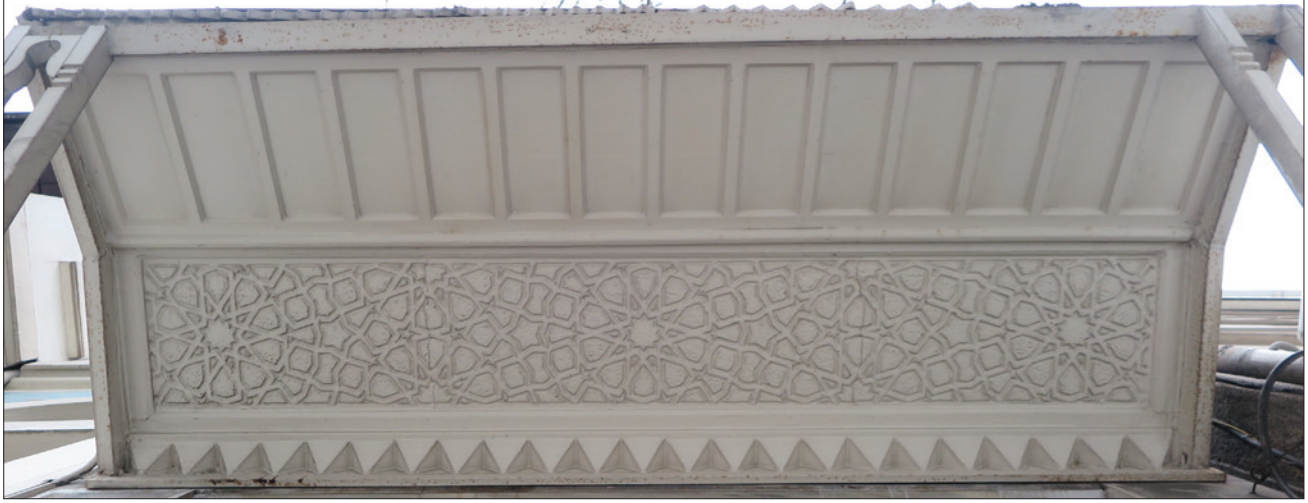
Fotoğraf 18 - Vedad Bey'in Valikonağı'nda bulunan evinden saçak detayı. Yapı Vedad Bey tarafından 1913-1914 yıllarında projelendirilmiştir. (M. Dila Gümüş, 2017) / The eave of Vedad Bey's house in Valikonağı. The builgind was designed by Vedad Bey in 1914.
