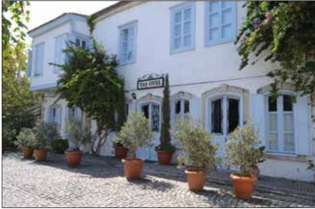
Fotoğraf 2. Konuttan konaklama tesisine işlev değişikliği örneği (Kaynak: Hekimoğlu,2016) / Example of functional change to housing accomodation (Source: Hekimoğlu, 2016)
