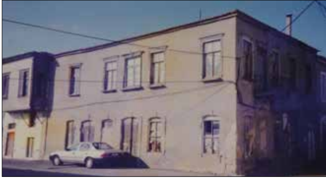
Fotoğraf 1. Konuttan konaklama tesisine işlev değişikliği örneği (Kaynak: Hekimoğlu,2016) / Example of functional change to housing accomodation (Source: Hekimoğlu, 2016)
