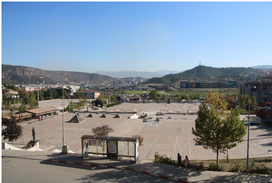
Şekil 1. Karabük Kent Meydanı ve Kardemir Demir-Çelik Fabrikası
