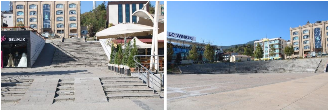
Şekil 2. Karabük Kent Meydanı merdivenleri ve amfi tiyatro
