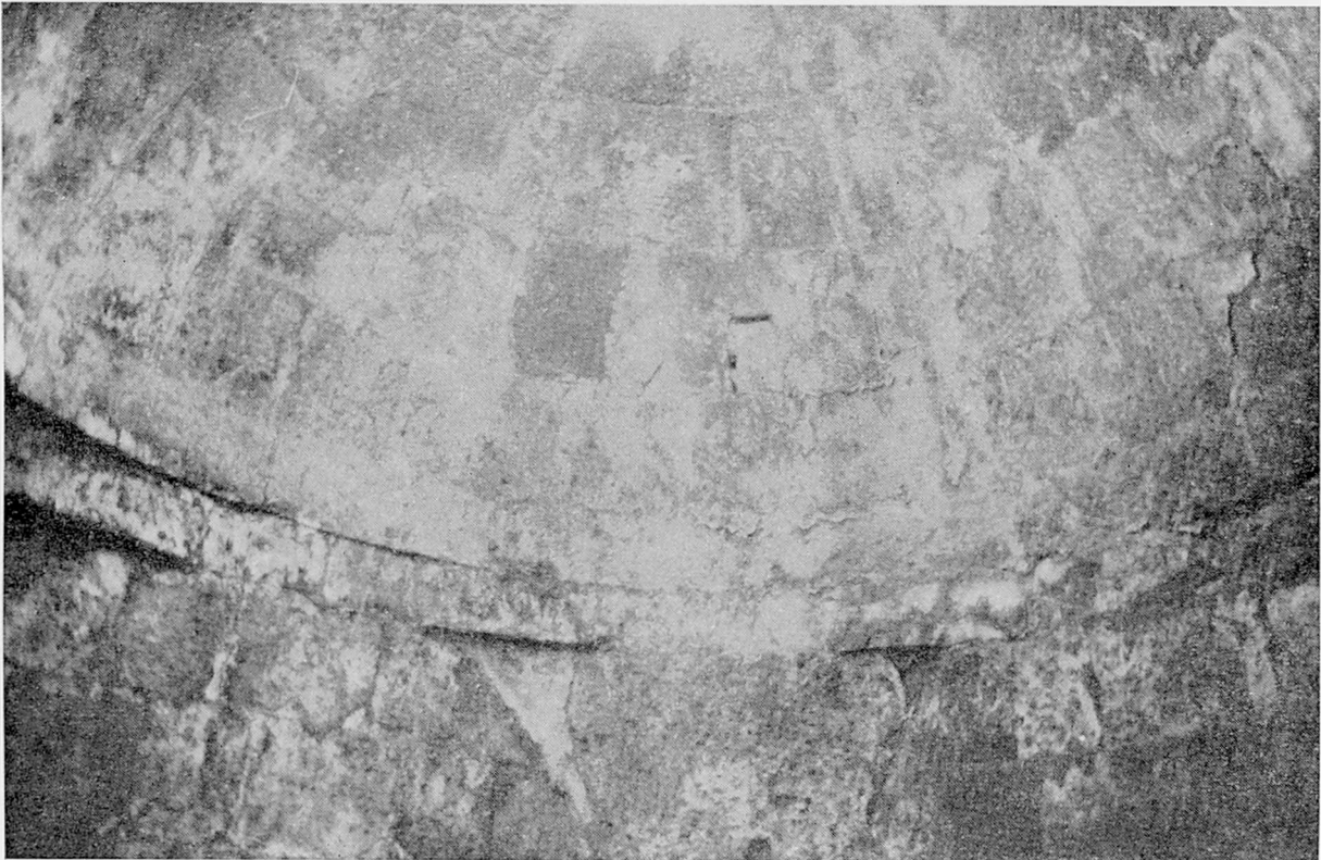
Res. 13 — Birinci halvetin içindeki taş kaplama.
