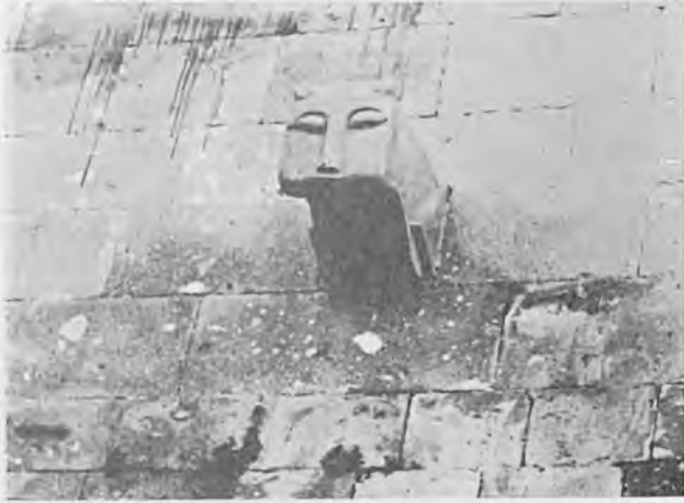
Res. 30 — Damsaköy Taşkın Paşa Cami çörtenci. Fig. 30 — Gutter at Taşkınpaşa Mosque, Damsaköy.
