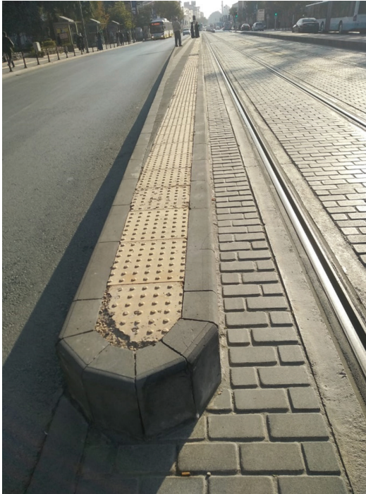
Fotoğraf 12: Mevlana Caddesi, tramvay yolu kaldırım düzenlemesi
