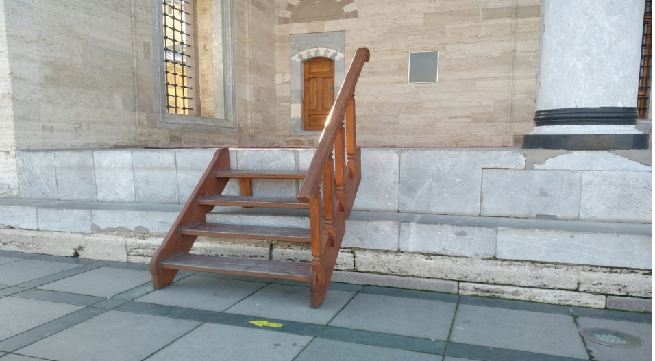
Fotoğraf 4: Konya Selimiye Camisi Girişi, ahşap merdiven
