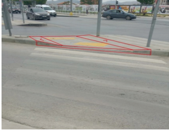
Şekil 5. Kışlaönü sokakta bulunan trafik ışıklarındaki kaldırım düzenlemeleri
