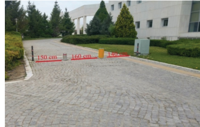
Şekil 7. Giriş noktalarında bulunan demir elemanlar
