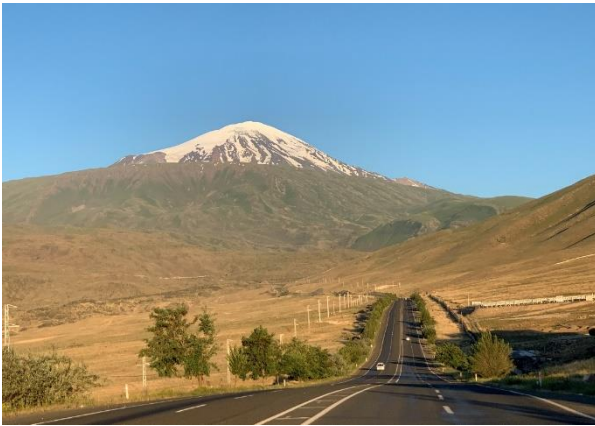
Photograph 3- Iğdır / Doğubeyazıt road access, Source: Adem Yulu
