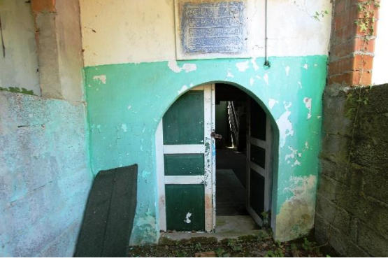
Res. 8: Kuzeybatı Cephe, Camiye Geçiş Kapısı
