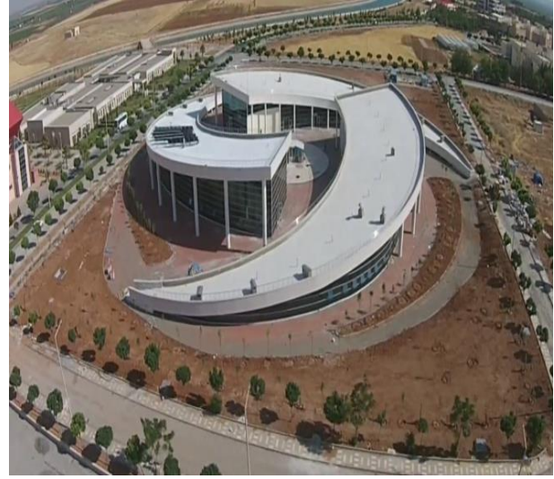
Şekil 2 GAP YENEV binasının kuş bakışı görünümü.
