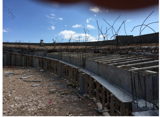
Şekil 17 Göçen çatı döşemesi için betonarme sistemle güçlendirme çalışmaları.
