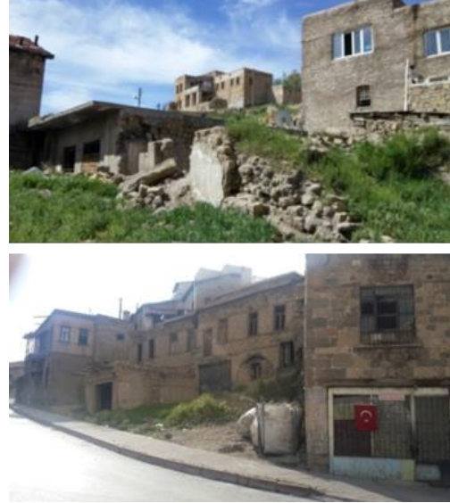
Resim 7. Kentsel sit alanında eğimli arazide bulunan konutlar, 2019
