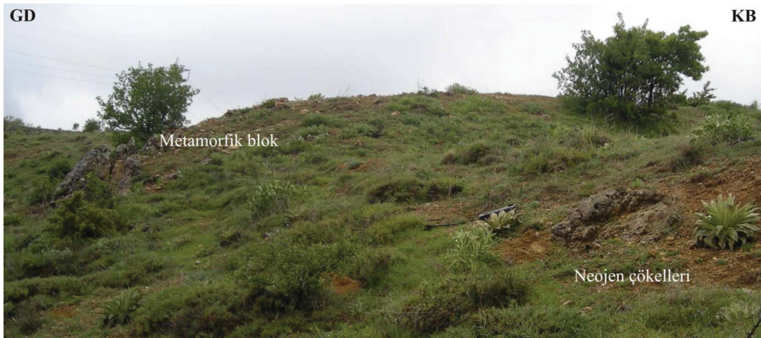
Şekil 8. Heyelanlı bölgede Neojen çökelleri üzerindeki metamorfik kayaç blokları. Figure 8. Metamorphic rock blocks on the Neogene sediments in the landslide area.
