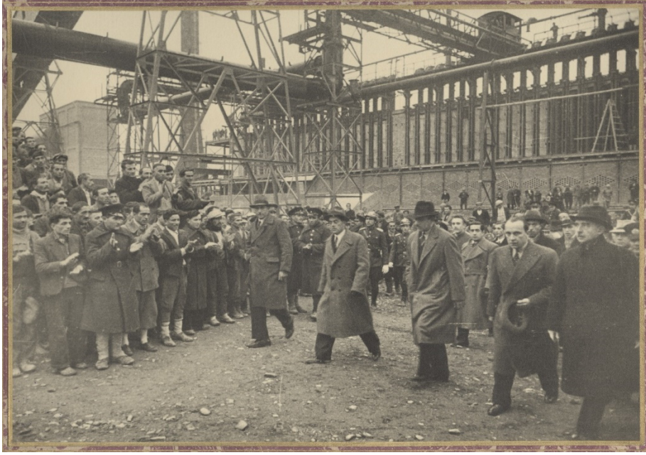
Cumhurbaşkanı İsmet İnönü, 1938 yılında Batı Karadeniz'i kapsayan gezisi sırasında Karabük'te yapımı devam eden Demir-Çelik Fabrikası'nı da gezerek inşaat faaliyetleri hakkında yetkililerden bilgi almıştır. (Foto: İnönü Vakfı Arşivi)
