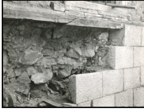
Şekil 7. Cami duvarı iç dolgusu (VGM, 2019)
