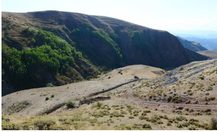
Resim 1: Kireçli Mahallesi, Harabelik mevkinde su isale hattı çalışmasının yapıldığı ve eserlerin bulunduğu alan
