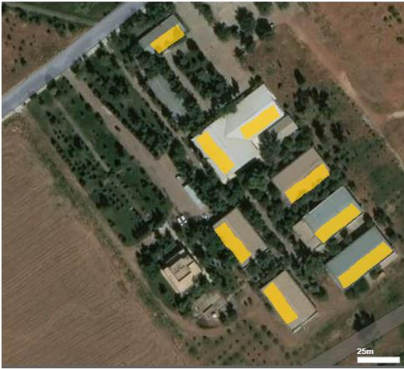
Şekil 1. Teknik Bilimler MYO'nun PV sistem ile elektrik üretimi için kullanılabilir çatı yüzeyleri
