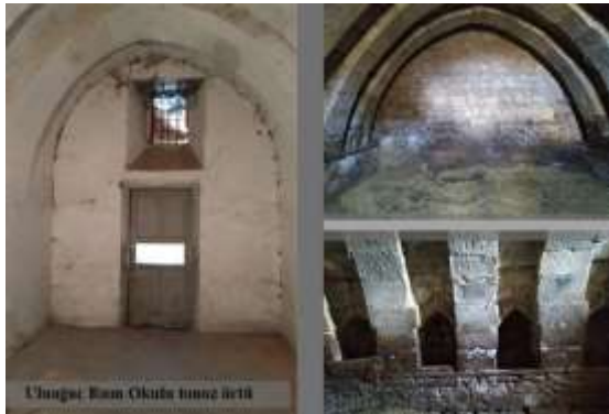
Şekil 18. Uluğağ Rum Okulu dersliklerin tonoz üst örtüleri (İlknur ACAR ATA,2019) (Figure 18. The vault covers of the classrooms of Uluğağ Greek School (İlknur ACAR ATA,2019))
