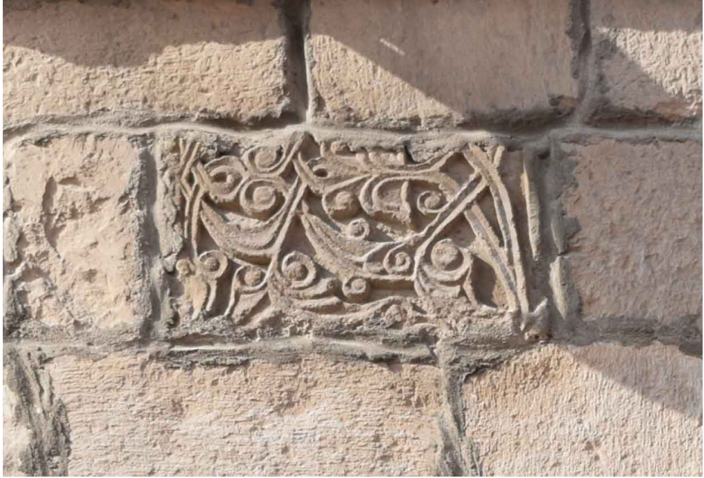
Foto. 15: Güney Cephe Taş Süsleme Ayrıntısı
