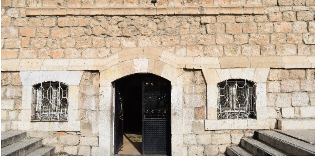
Foto. 2: Gazi İlkokulu Batı Cephesindeki Bodrum Kata Açılan Kapı Açıklığı
