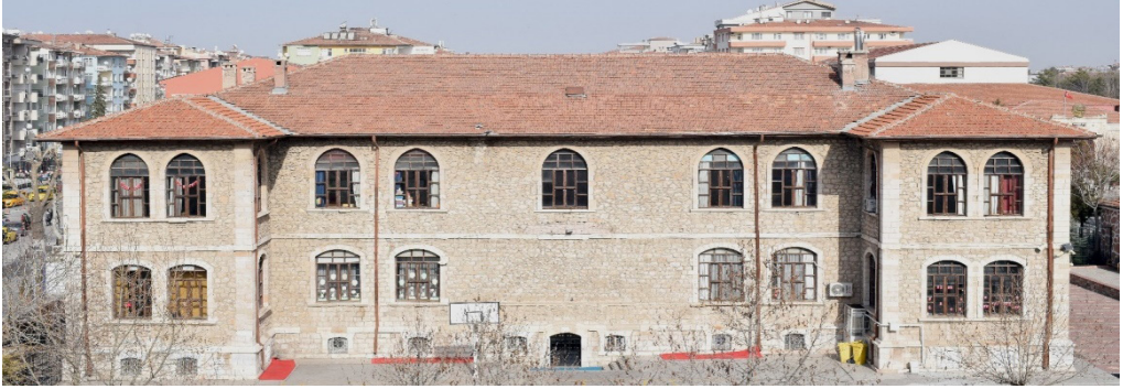
Foto. 13: Gazi İlkokulu Batı Cephesi
