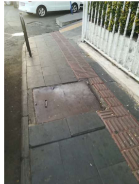
Şekil 23. Hissedilebilir yüzeylerdeki malzeme yönü
