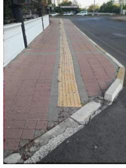
Şekil 8. Uyarıcı yüzeyin kullanılması gereken durum
