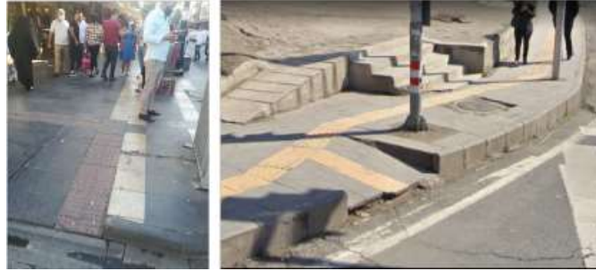
Şekil 14. Kaldırım rampasındaki düzenlemeler
