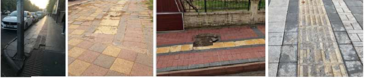
Şekil 18. Hissedilebilir yüzeylerdeki bozulmalar
