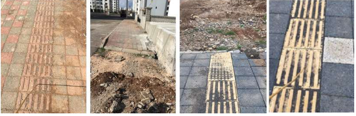
Şekil 27. Hissedilebilir yüzeyin farklı malzeme ile örtülmesi ve kesintiye uğraması
