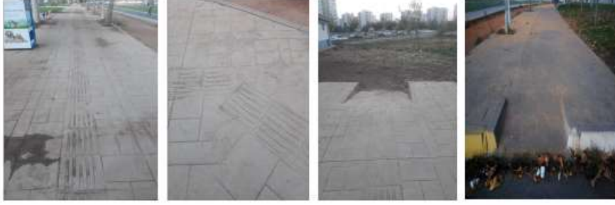
Şekil 24. Zeminle aynı renkte olan hissedilebilir yüzeyler
