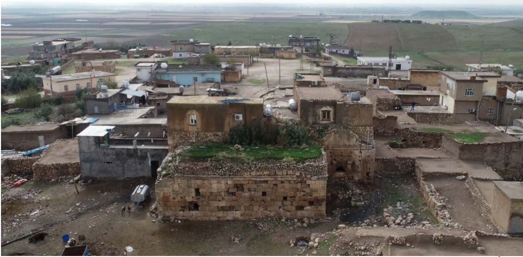
Fot. 9. Kilisenin kuzeybatısından görünüş, üçgen alınlıklı giriş (Fot. Tehsin BARAVİ).
