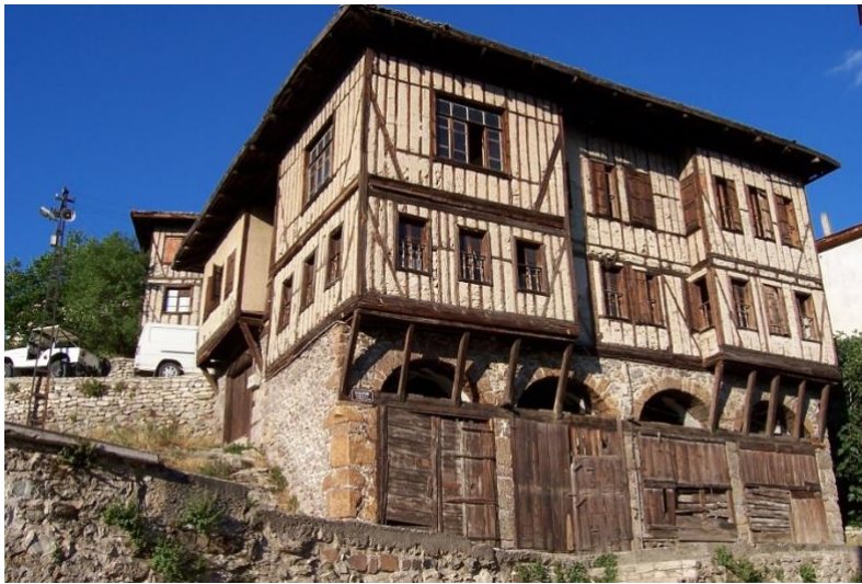
Şekil 6. Ahşap taşıyıcı kerpiç dolgu sistemi ile yapılmış bir konut örneđi (Kaynak: World All Details, 2020).
