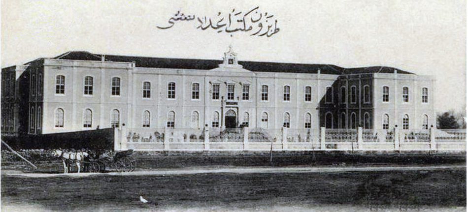
G. 11: Kırşehir, Yozgat, Ankara ve Kayseri İdadileri ile Tıp Proje Arz Eden Trabzon Mekteb-i İdadi Mülkiyesi (Avcı, “Osmanlı Hükümet Konakları Tanzimat Döneminde Kent Mekânında Devletin Erki ve Temsili” 227)
