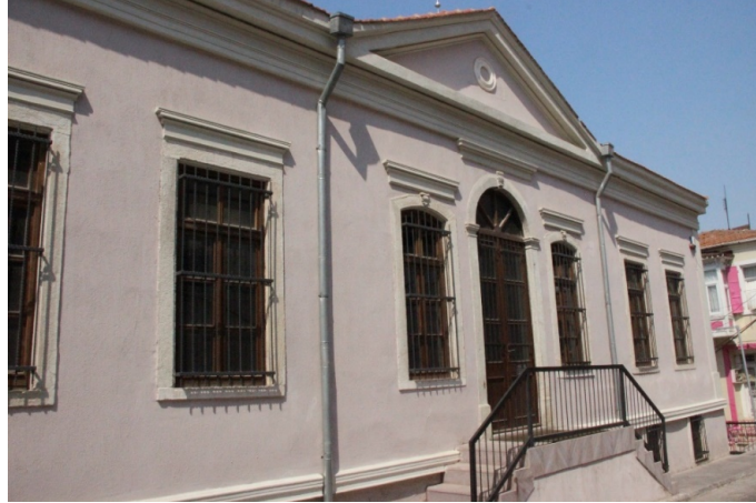
Şekil 31. İzmir Cumhuriyet Eğitim Müzesi, A Blok güney cephe, restorasyon sonrası
