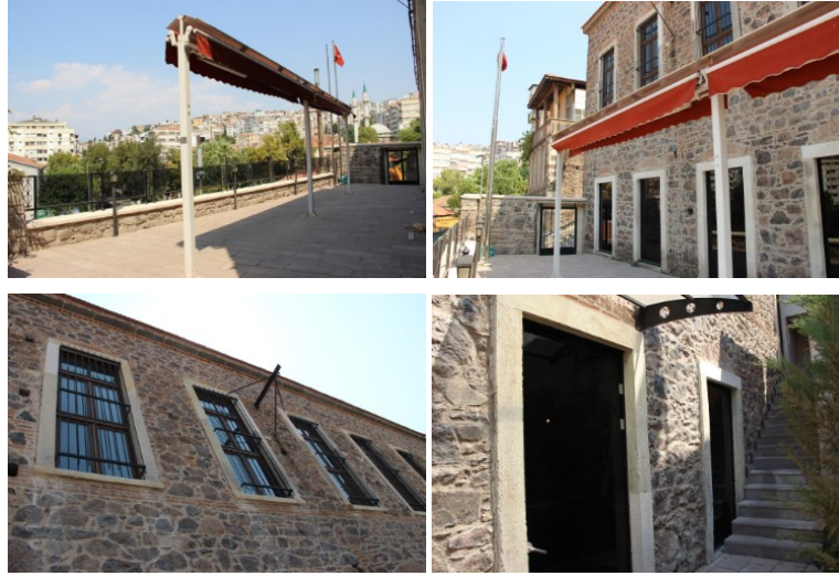
Şekil 37. İzmir Cumhuriyet Eğitim Müzesi, B Blok kuzey cephe ve bahçe, restorasyon sonrası
