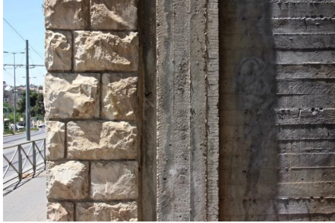
Şekil 10: Dastor taşı ile kaplama detayı
