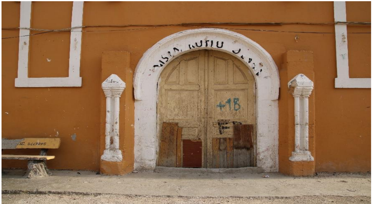
Resim 11. Yapının Kuzeybatıdaki Ana Kapısı
