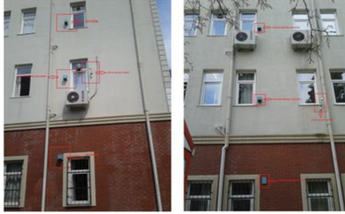
Şekil 3. Mühendislik Fakültesi C Blok Cepheden Görünüm
