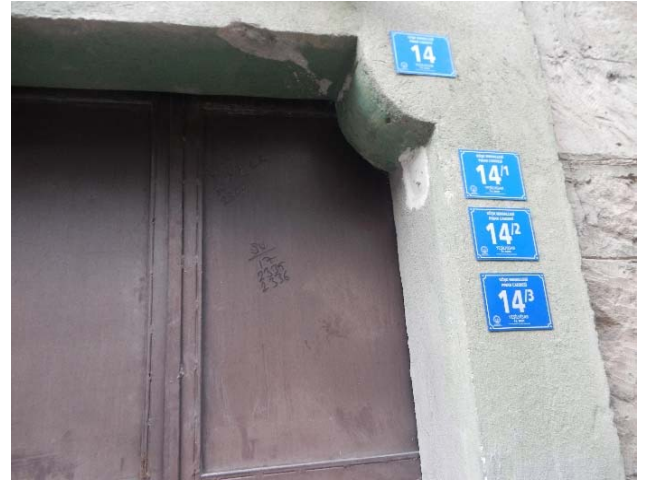
Şekil 6 Çoklu Kapı Numarası (Multiple House Numbers)
