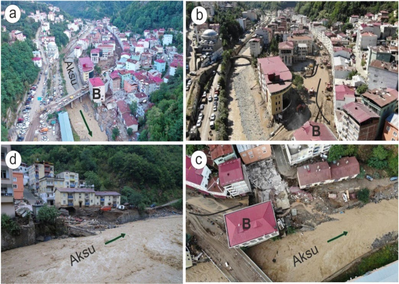
Şekil 13. Dereli meydanında ve aşağısında sediment birikimi ve su akışını etkileyen unsurlardan, arkasındaki meydana göre kötü yüksek olan Aksu köprüsüne bitişik Halk Eğitim Binasının çeşitli açılardan görüntüleri ve akışın yönlendirilmesi (a, b, c) ve binanın solundaki boşluktan akan suyun etkisiyle yıkılan ve hasar gören binalar (d) (foto a: ihh.org.tr , b: twitter.com , c: hicrethaber.com , d: dogruhaber.com ).
