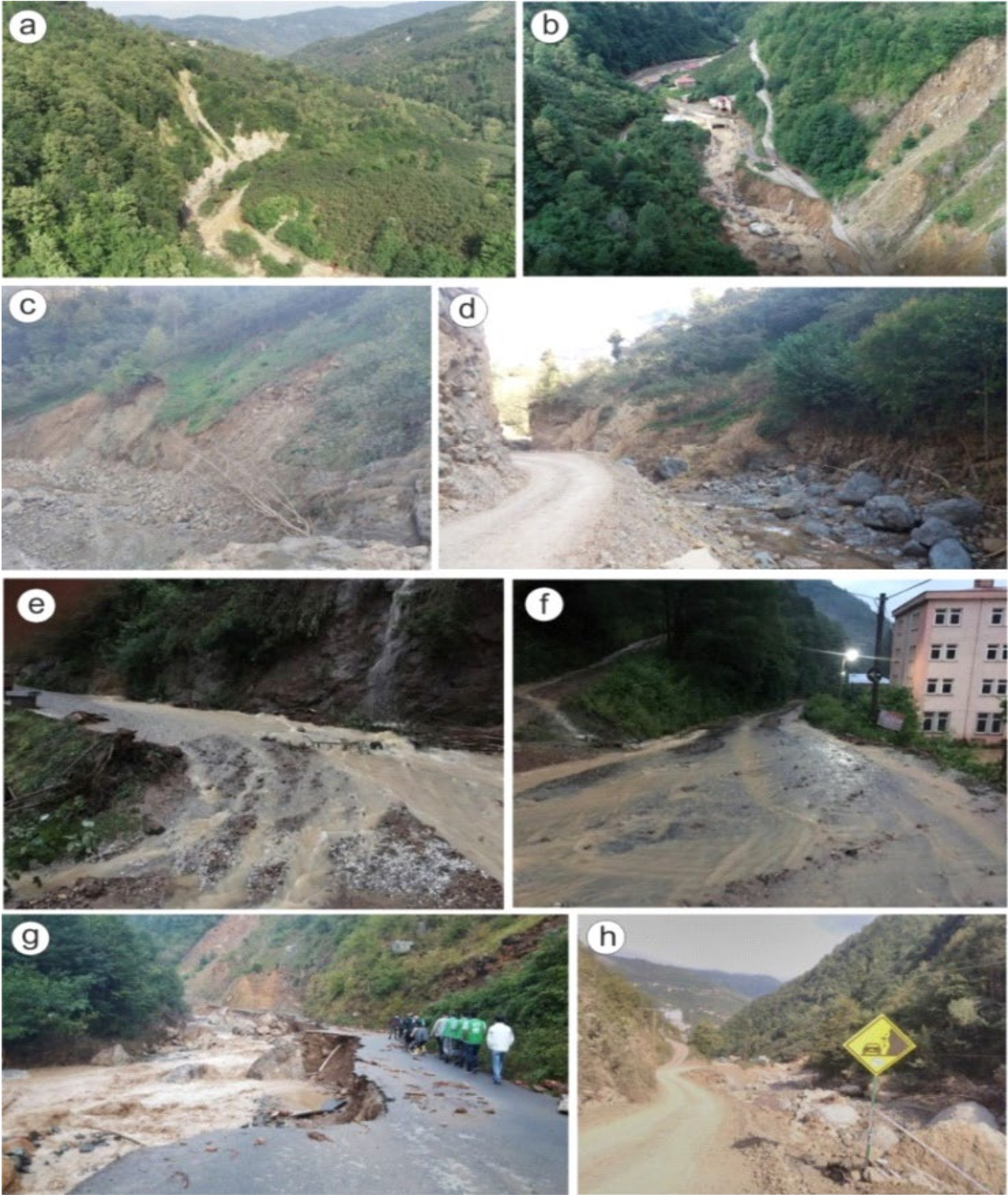
Şekil 11. Dereli Deresi'nin sediment yükünde etkili olan dik yamaçların erozyonu, heyelanlar ve aşınan yol dolgularından görüntüler (a,b: DSİ 226. Şube, c,d,h:A.Apaydın, e: medyatilkisi.com, ,f,g: akkayakoyu.org).
